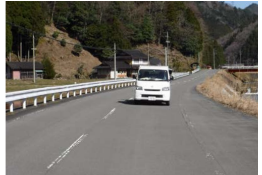
二車線の広い道
