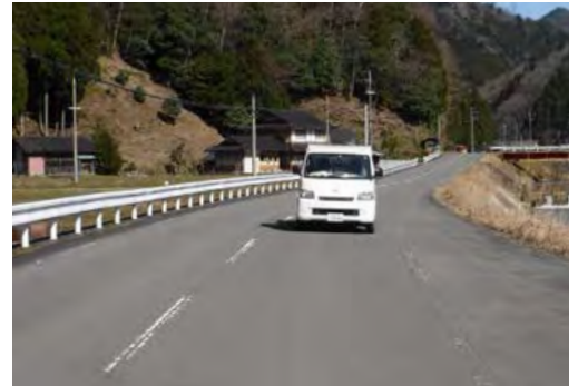
二車線の広い道
